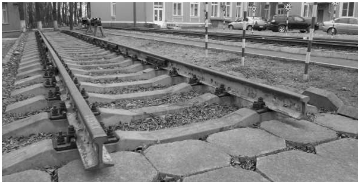
Фото 20 - Тупик для занятий по дефектоскопии рельсов
