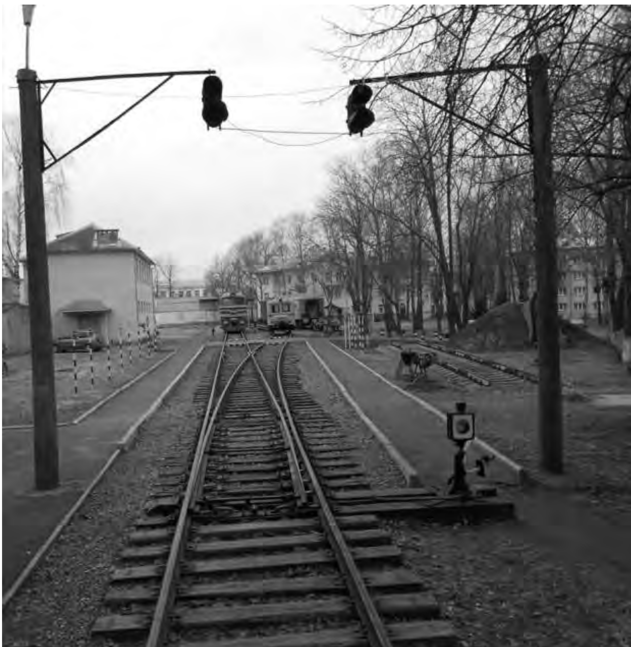
Фото 1 – Общий вид учебного полигона
