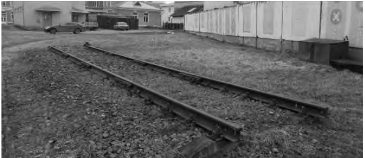
Фото 21 - Тупик для ремонта верхнего строения пути
