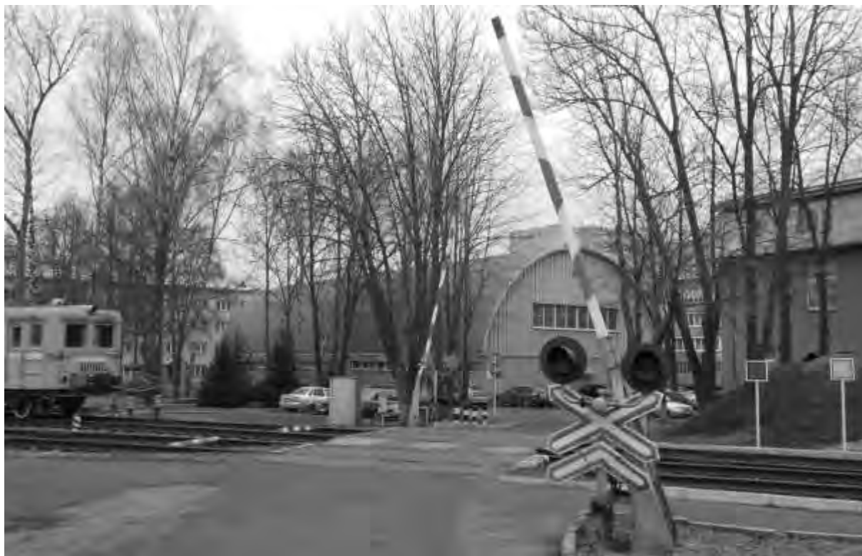
Фото 14 - Железнодорожный переезд с автоматическим шлагбаумом
