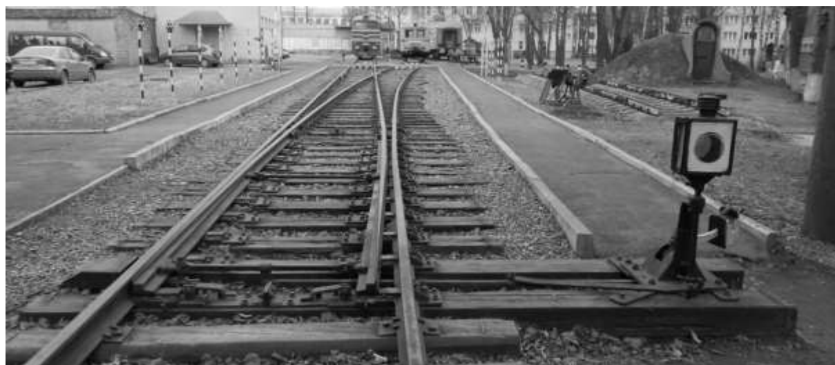
Фото 18 – Стрелочный перевод с ручным управлением
